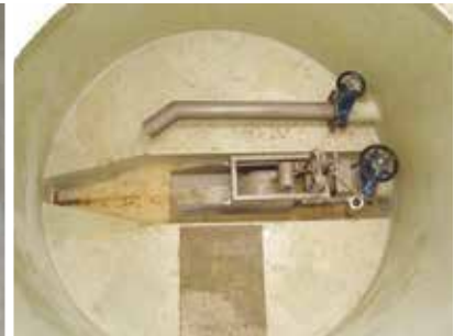
Elektrische Drossel, Trockenaufstellung Mechanische Drossel, Halbtrockenaufstellung
