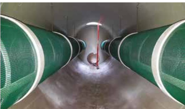
Stauraumkanal mit Amiblu Amiscreen-Elementen. Durch die großen Siebflächen werden Grobstoffe im Stauraum zurückgehalten.
