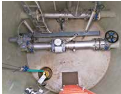
Elektrische Drossel, Trockenaufstellung Mechanische Drossel, Halbtrockenaufstellung
