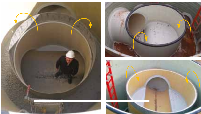
Перелив дождевой воды из канализационных трубопроводов: выход потока из канализационного трубопровода (слева), направление потока в раструбный лоток (вверху справа) и перелив в канализационную трубу (внизу справа).
