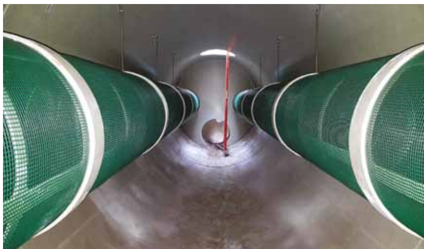
Накопительная канализация с системой сепарации загрязняющих веществ Amiscreen. Большой объем системы эффективно фильтрует твердые частицы, перекачиваемые вместе со сточными водами.
