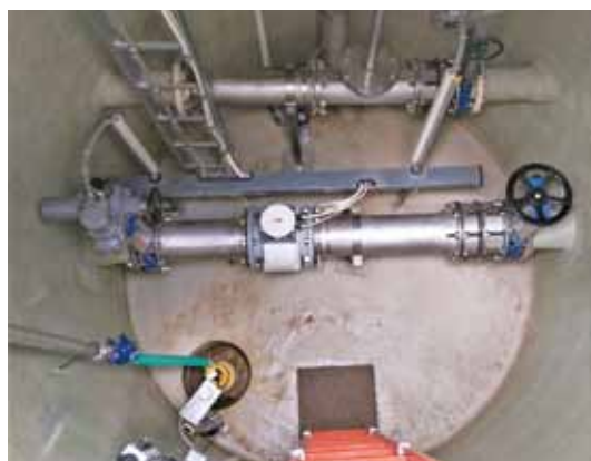
Электрический регулятор потока – работа в сухих условиях
