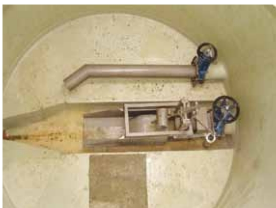
Регулятор потока с функцией взвешивания – работа в полусухих условиях
