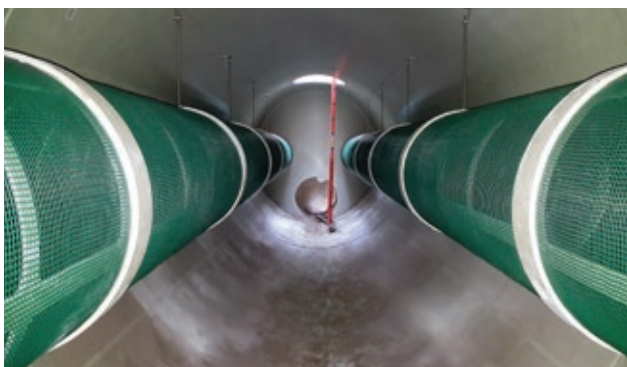
Kanalizacja magazynująca z systemem separacji zanieczyszczeń Amiscreen. Duże powierzchnie systemu separacyjnego skutecznie filtrują ciała stałe ze ścieków.
