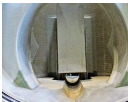
Po lewej: wirowy regulator przepływu, instalacja na mokro Po prawej: pływakowy regulator przepływu, instalacja na mokro
