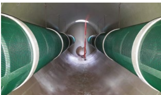
Infrastructure de stockage avec éléments Amiscreen. Leurs surfaces filtrent les solides en suspension issus des eaux usées.
