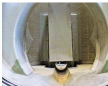
Gauche Vanne d'étranglement installée dans un dispositif souterrain. Droite: Vanne d'étranglement à flotteur mécanique installée dans un dispositif souterrain.
