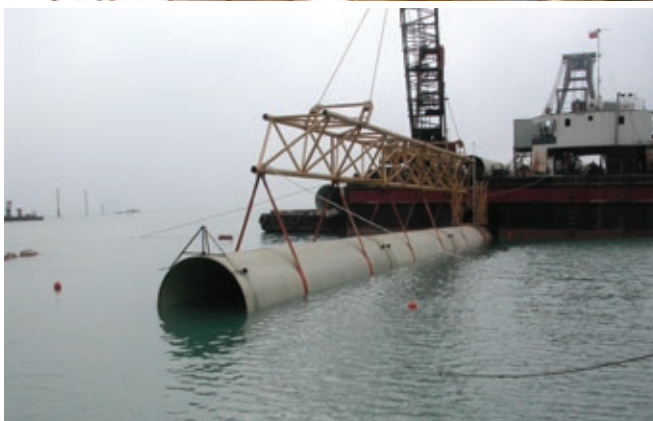
Zdjęcia od góry: Instalacja przenosząca obciążenia wzdłużne. Instalacja nieprzenosząca obciążeń wzdłużnych. Instalacja metodą przecisku.
