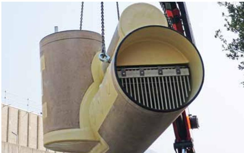
Links oben: Der CSO chamber wurde in nur 1 Tag erfolgreich versetzt. Rechts unten: Der hocheffektive Grobstoffrechen aus flexiblen GFK-Stäbchen. Rechts oben: Das Projektteam leistete ganze Arbeit und ist stolz auf das optimale Resultat.
