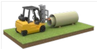
Abb. 5: Entschachtelung der Rohre mit Gabelstapler
