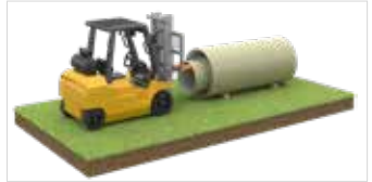
Abb. 5: Entschachtelung der Rohre mit Gabelstapler
