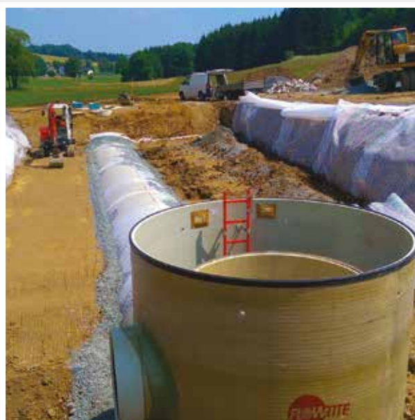
Drosselschacht mit halb trocken aufgestellter Drossel
