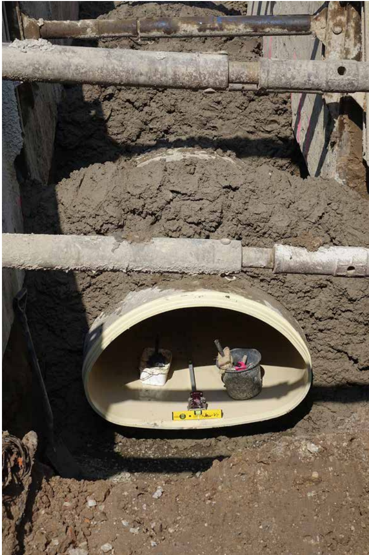
Das Amiblu GFK-Rohr mit Maulquerschnitt wird in offener Bauweise verlegt.
