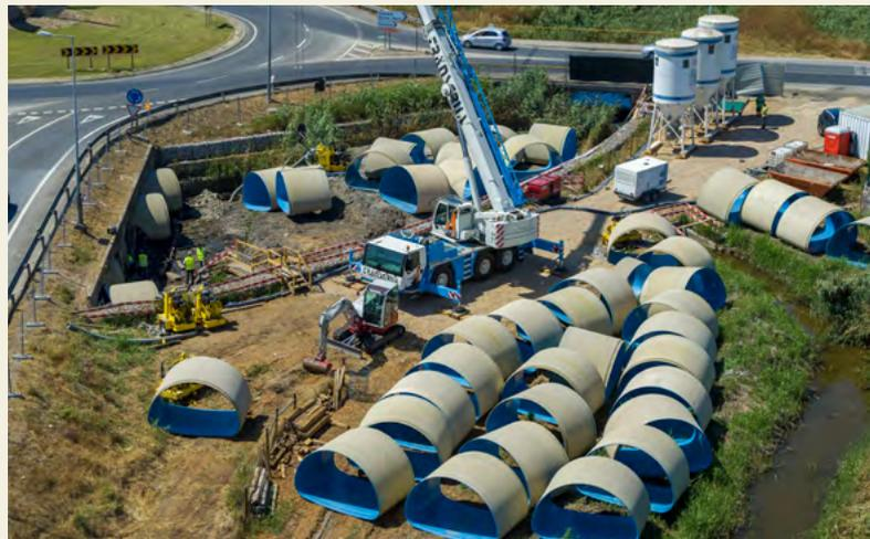
Il **profilo ad arco** è ideale per condotte di drenaggio sottostrada, destinate al convogliamento di torrenti e ruscelli. La forma consente inoltre l'ispezione da parte del personale preposto.
