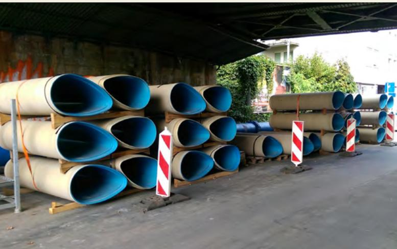
Il **profilo ovoidale** è ideale per le fognature miste. La parte stretta nella sezione inferiore del tubo assicura una buona portata per i liquami, mentre la sezione superiore più larga è in grado di gestire le forti precipitazioni.
