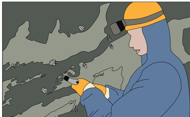
Rys. 16: Przygotowanie powierzchni starego kanału
