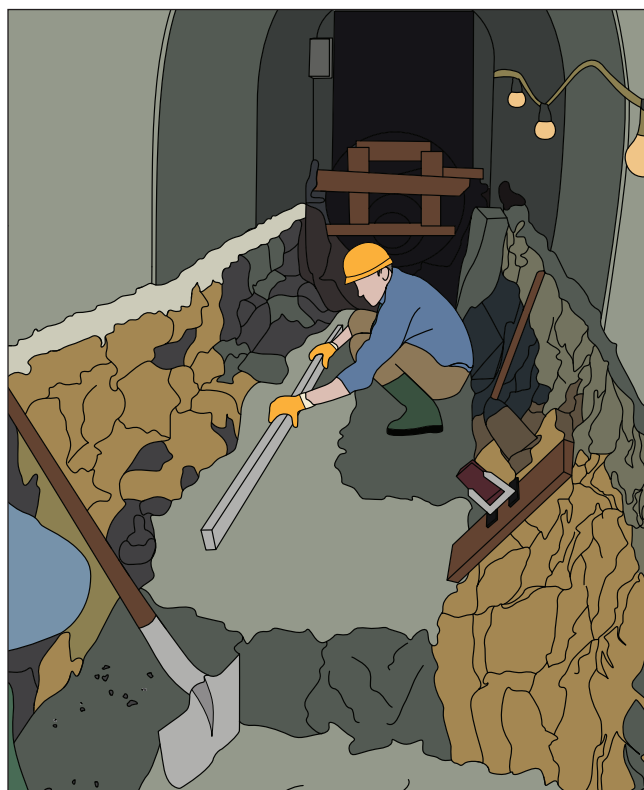
Rys. 17: Przygotowanie dna istniejącego kanału w celu prawidłowej instalacji rur niekołowych
