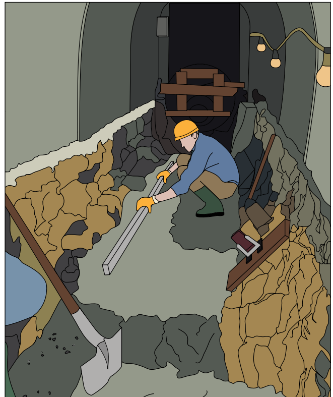
Abb. 17: Boden des Altkanals für eine ordnungsgemäße Installation vorbereiten
