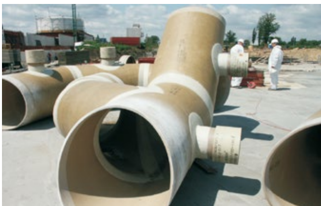
Serwis na placu budowy oczyszczalni ścieków.
