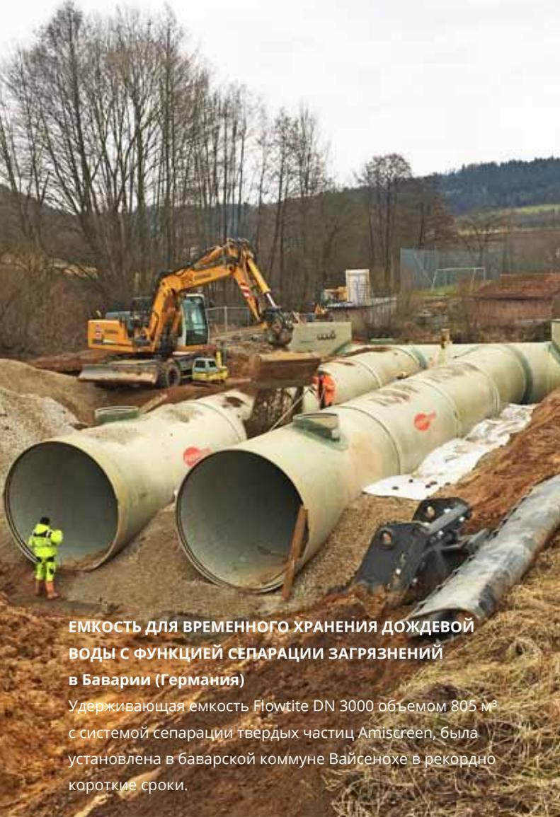
**ЕМКОСТЬ ДЛЯ ВРЕМЕННОГО ХРАНЕНИЯ ДОЖДЕВОЙ ВОДЫ С ФУНКЦИЕЙ СЕПАРАЦИИ ЗАГРЯЗНЕНИЙ в Баварии (Германия)**
