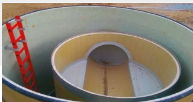
Pozo de descarga y aliviadero
