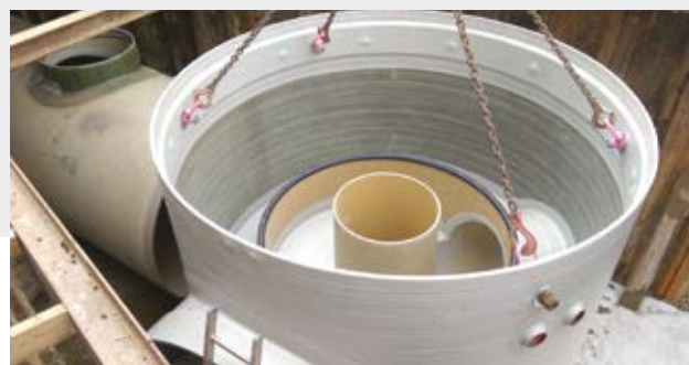
Desbordamiento de emergencia
