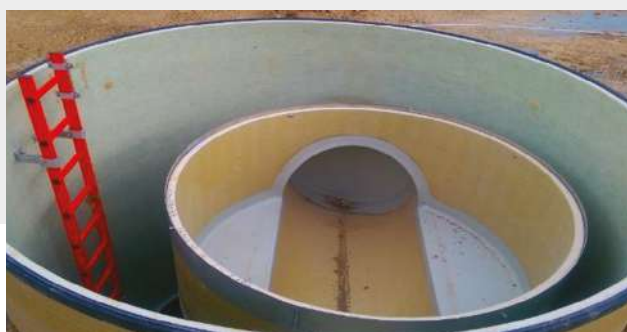
Estrutura do açude
