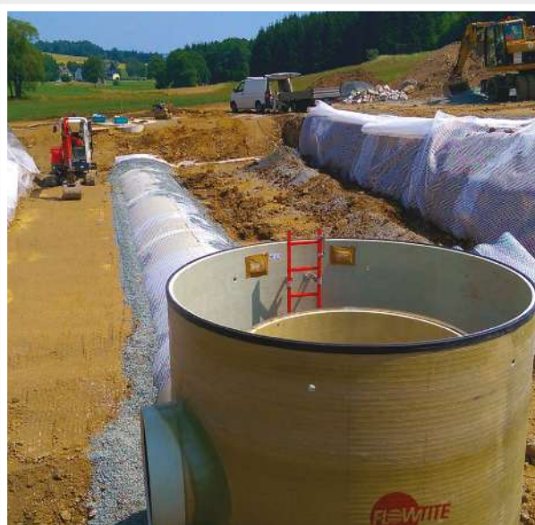
Transbordo de águas pluviais, reservatório
