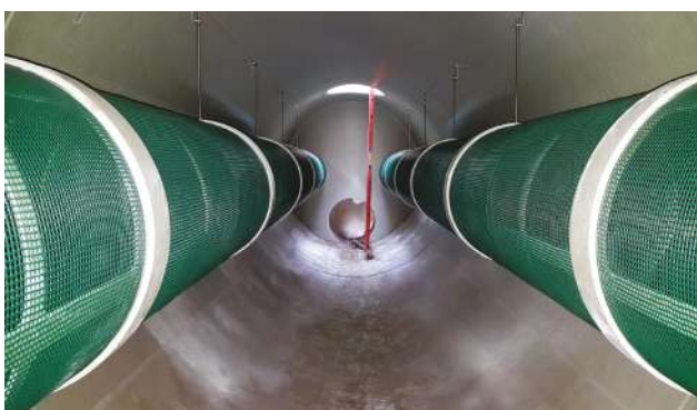
Esgoto de armazenamento com elementos Amiscreen da Amiblu. As grandes superfícies de filtração filtram eficazmente os sólidos em suspensão das águas residuais.
