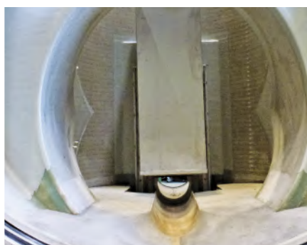
Esquerda: válvula redutora de caudal sem partes móveis, instalação em poço húmido
