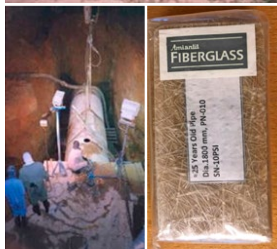
Rys. 9-11: Rura kanalizacyjna Flowtite GRP o średnicy DN 1800, którą odkopano i zbadano po niemal 25 latach eksploatacji w oczyszczalni ścieków w Rijadzie (Arabia Saudyjska). Rura nie wykazywała oznak zużycia.
