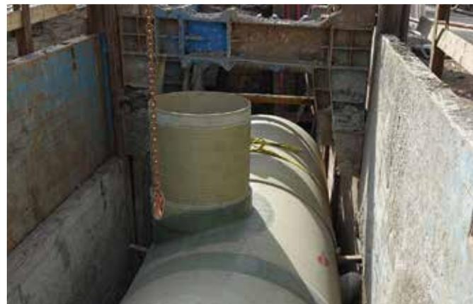
Flowtite Staukanal DN 2300 mit Zulauf- und Durchflusskontrollschacht
