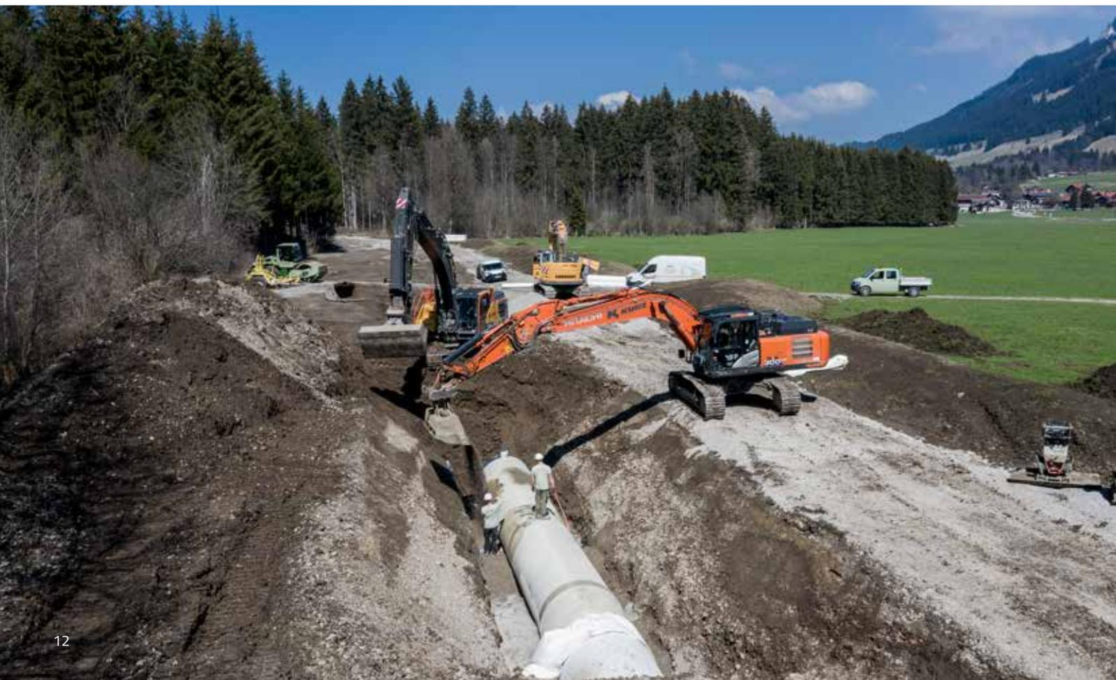
Aus wirtschaftlichen Gründen sollte die GFK-Druckrohrleitung im offenen Graben mit geringer Überdeckung installiert werden – eine Vorgehensweise, die zu verschiedenen Hoch- und Tiefpunkten entlang der Rohrleitung führte. An den Hochpunkten wurden Entlüftungseinrichtungen vorgesehen, während an den Tiefpunkten das Wasser zu Inspektionzwecken abgepumpt werden kann.
