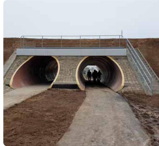
Zwei parallele Rohrleitungen De 3600 mit einer Nennsteifigkeit von SN 64.000 wurden in etwa einem Monat unter den in Betrieb befindlichen Bahngleisen durchgedrückt. Um den Durchlass auf die Böschungsneigung auszurichten, wurden an den Tunnelenden speziell abgeschrägte Rohre eingebaut. Schließlich wurde die Rohrsohle mit Beton gegossen, Leuchten sowie Schutzwände installiert und die Fußgänger-/Fahrradwege für die Nutzung freigegeben.
