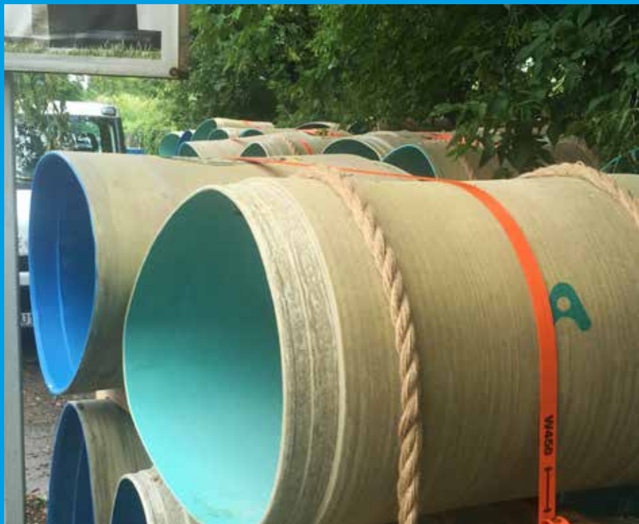
Oben: 746 m Amiblu NC Line Rohre in verschiedenen Querschnitten wurden innerhalb von acht Monaten verlegt, um Teile des alten Kanalsystems in Krakau zu sanieren.
