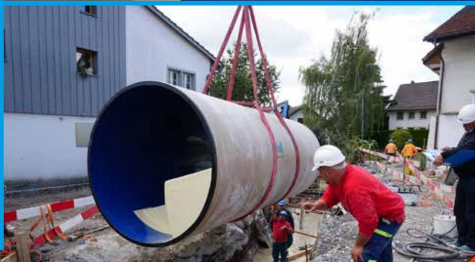
Die Hobas PU Line Rohre DN 1800 wurden maßgeschneidert mit einer Fischtreppe und Sedimentbarrieren gemäß den Projektanforderungen produziert.
