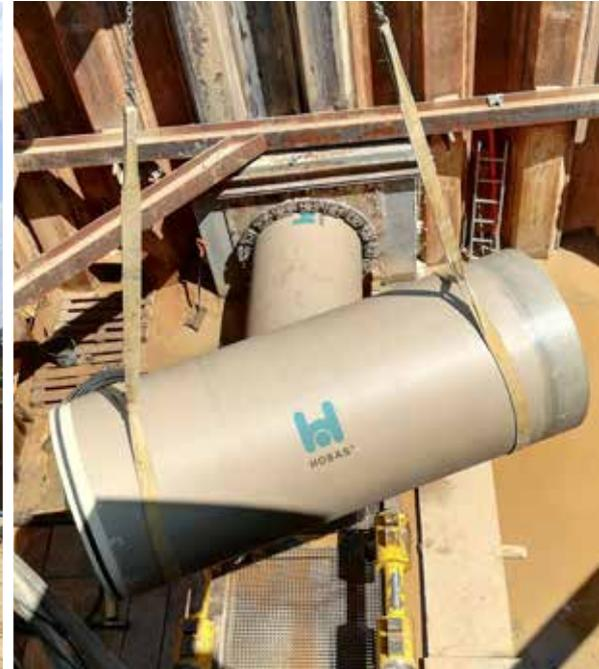
Oben links: In Vortriebsrohre von Hobas wurden Flowtite-Rohre mit Distanzringen eingesetzt, um ein nachhaltiges und zuverlässiges Rohr-in-Rohr-System zu schaffen.
