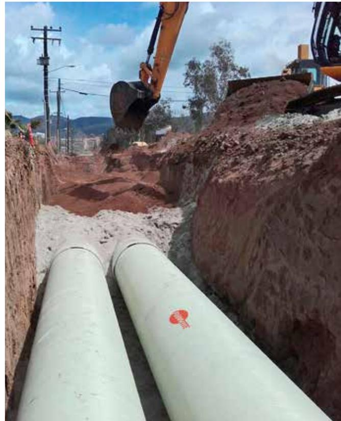
*Oben rechts: GFK-Rohre DN 1000 transportieren die Sole zum Meer. Unten: lackierte biaxiale Flowtite-Rohre, um die verschiedenen Stufen des Entsalzungsprozesses zu kennzeichnen.*
