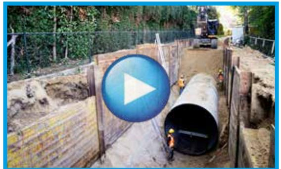
*Der alte, beschädigte Abflusskanal aus Beton wurde durch einen Amiblu GFK-Stauraumkanal ersetzt, um zukünftig Überschwemmungen zu verhindern*
