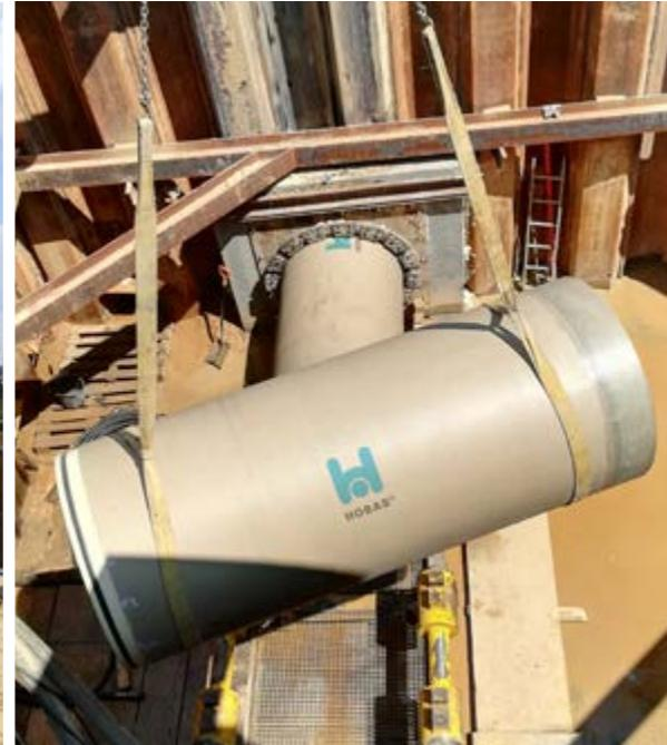
*A gauche : Tuyaux Flowtite équipés de centreurs et insérés dans les tuyaux de microtunnelage Hobas afin de créer un système double-tube pérenne. A droite : Tuyaux Hobas utilisés pour le fonçage sous route.*
