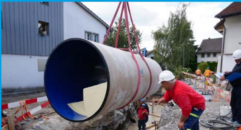
*Tuyaux Hobas PU Line DN 1800 fabriqués sur mesure. Ils sont équipés d'une passe à poissons et de barrettes de surverse.*
