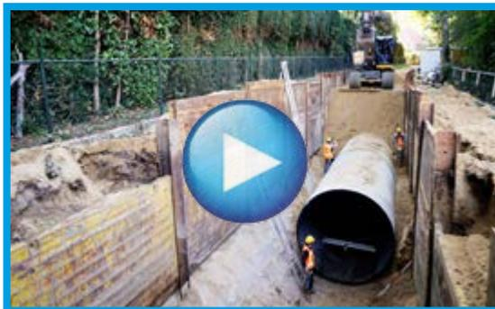
*La vieille conduite en béton a été remplacée par un réservoir de stockage Amiblu en PRV pour prévenir toute nouvelle inondation*
