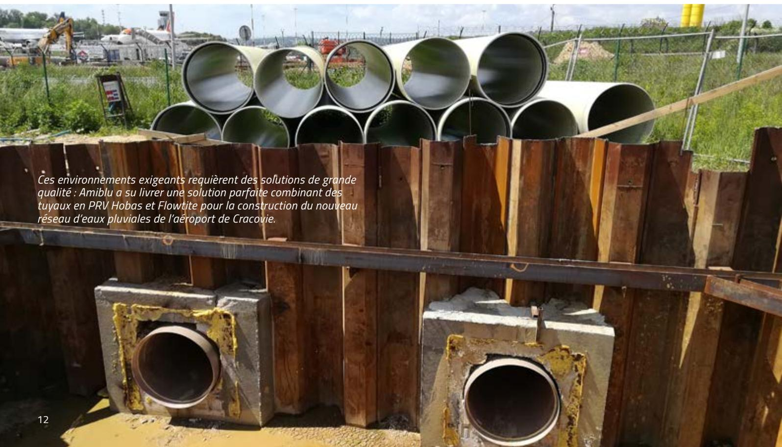
*Ces environnements exigeants requièrent des solutions de grande qualité : Amiblu a su livrer une solution parfaite combinant des tuyaux en PRV Hobas et Flowtite pour la construction du nouveau réseau d'eaux pluviales de l'aéroport de Cracovie.*
