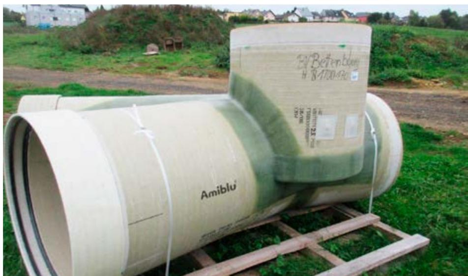
*De haut en bas : Tuyaux Flowtite OD 1280 installés par microtunnelage sous l'autoroute A3 (photos 1 et 2). 1200 m de tuyaux et pièces de raccord Flowtite DN 1000 ont été installés en tranchée ouverte (photos 3).*
