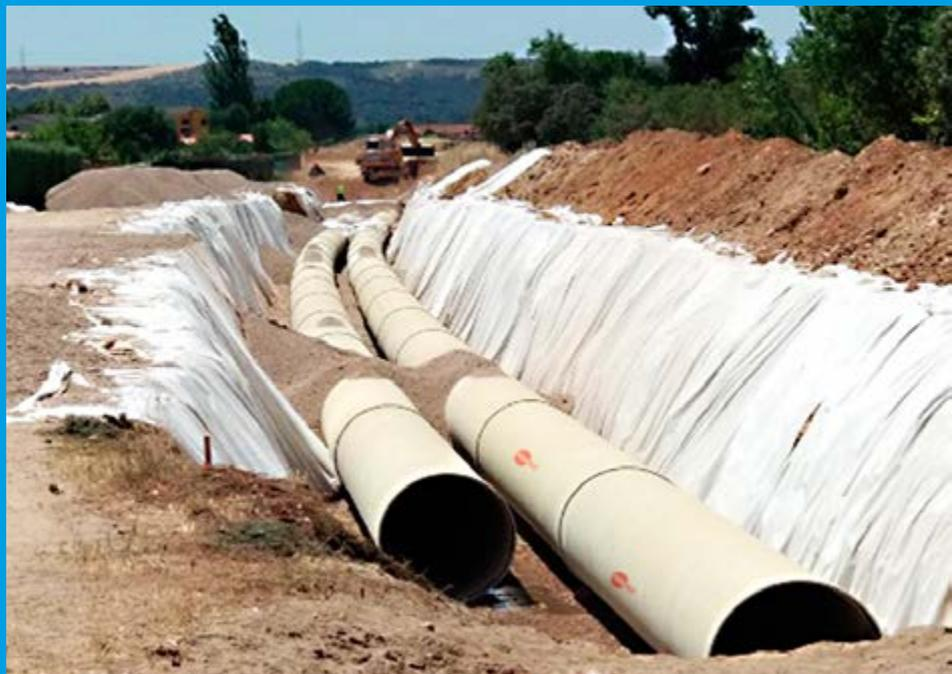
*Ci-dessus: Amiblu a livré 7,5 km de tuyaux en PRV DN 1600, de nombreux coudes et pièces pour ce nouveau système d'irrigation.*
