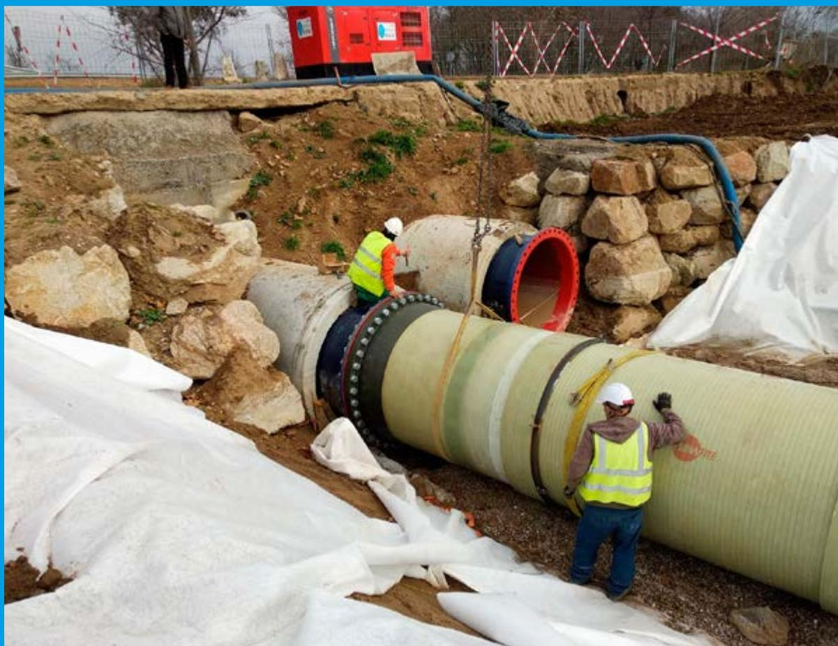
*Selon les réglementations nationales, les conduites croisant les routes et voies ferrées doivent être renforcées à l'aide de tuyaux béton installés par microtunnelage et dans lesquels des tuyaux acier sont introduits. Les tuyaux acier et PRV ont été raccordés à l'aide de brides de part et d'autre des intersections.*
