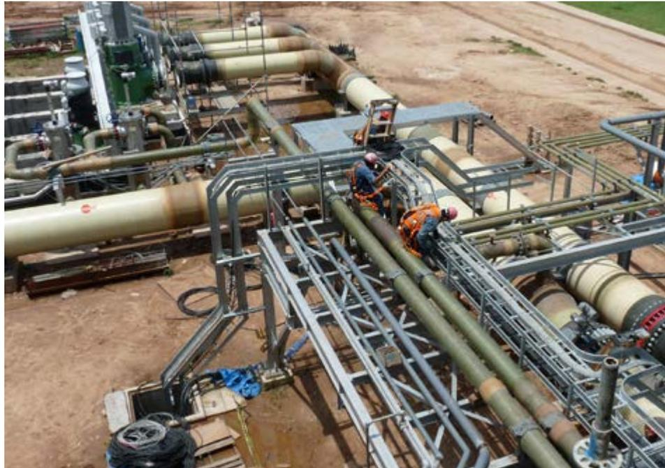
*Amiblu a livré des tuyaux Flowtite pression résistants à la traction DN 1000 et DN 700 aux deux centrales électriques.*
