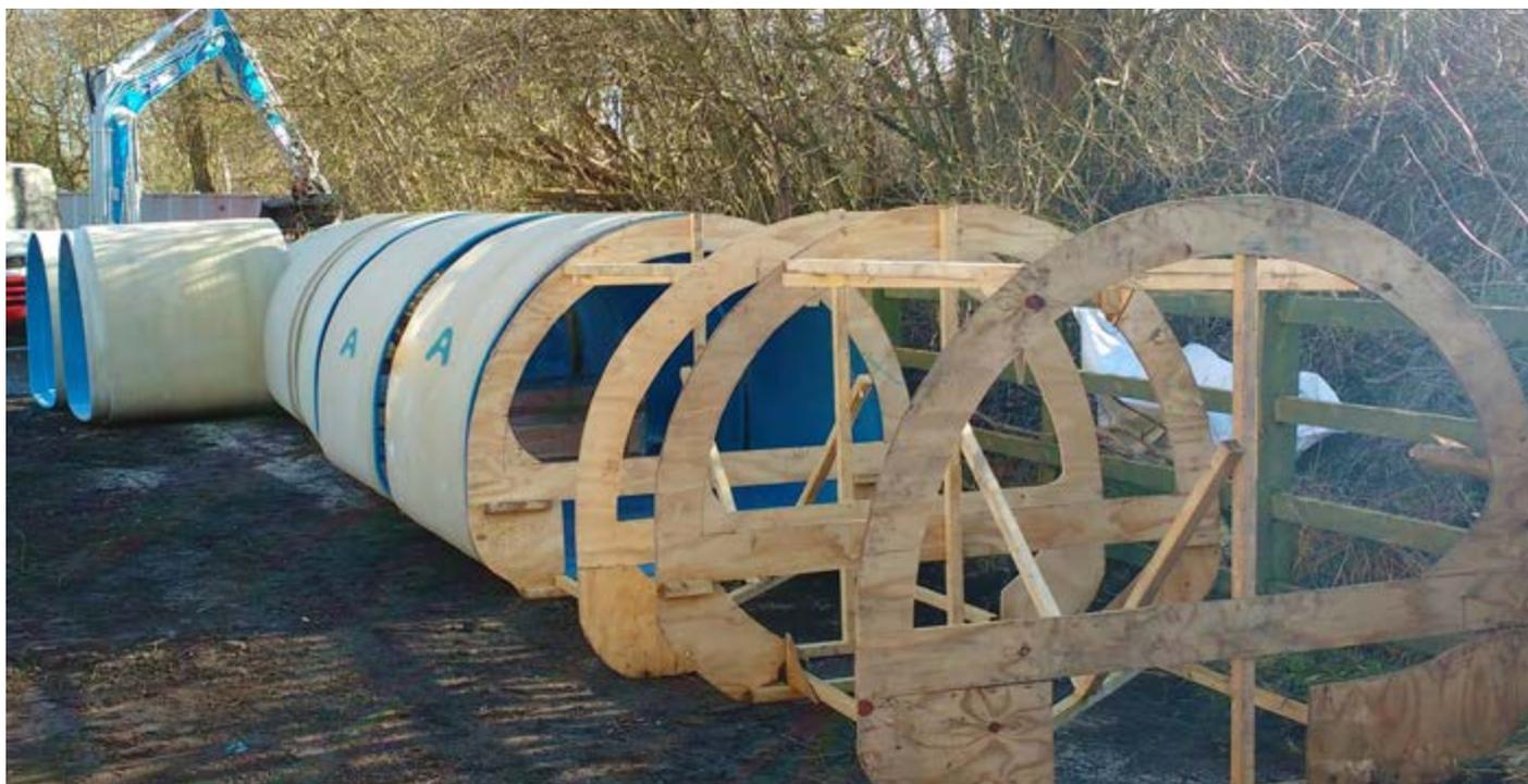
*Ci-dessus: Un gabarit en bois de la forme des éléments NC Line a été passé dans l'ouvrage en amont des travaux et a aidé à identifier les éventuelles zones qui ne seraient pas conformes à la forme des tuyaux. Ci-dessous: la conduite NC Line Amiblu finalisée présentant une stabilité structurelle et une résistance à la corrosion parfaites.*
