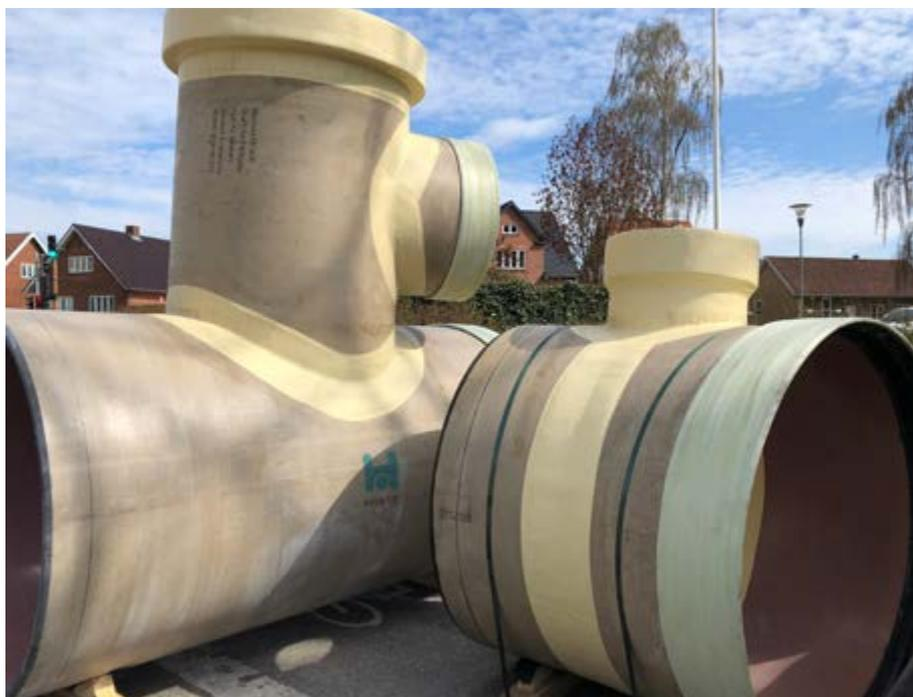
*Ci-dessus: Environ 400 m de tuyaux Hobas en PRV DN 1600, dont plusieurs regards et pièces de raccord, ont été installés en tranchée dans le cadre du projet de réhabilitation de la ville de Fredericia.*
