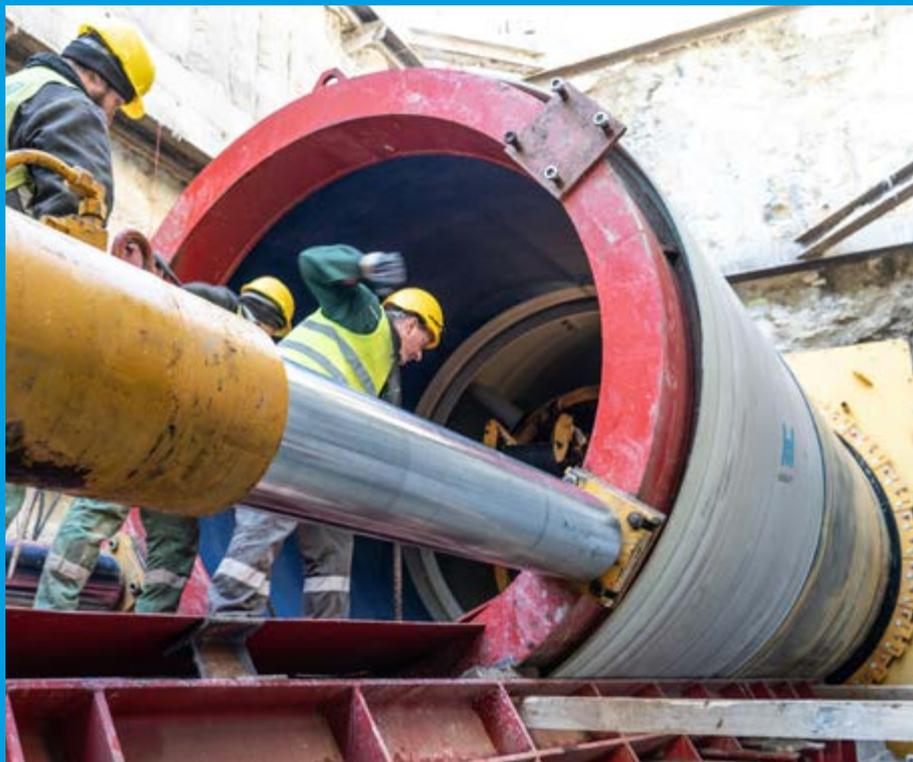
*Ci-dessus: Dext 3000 – les plus gros diamètres de la gamme Hobas PU Line installés par microtunnelage jusqu'à présent. Ci-dessous: tuyaux Flowtite jusqu'à DN 2800 installés en tranchée.*
