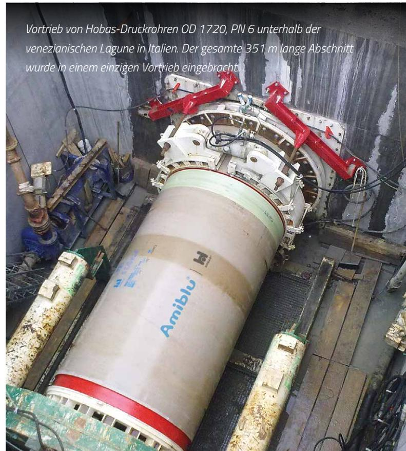
*Vortrieb von Hobas-Druckrohren OD 1720, PN 6 unterhalb der venezianischen Lagune in Italien. Der gesamte 351 m lange Abschnitt wurde in einem einzigen Vortrieb eingebracht.*
