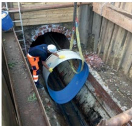
Les tuyaux en PRV Amiblu peuvent être installés facilement, et avec une faible empreinte carbone, au moyen de technologies sans tranchées telles que le microtunnelage ou le retubage. Ces technologies sont particulièrement pratiques quand les conduites doivent être posées dans des zones densément peuplées comme les centres-ville, les zones naturelles protégées, ou bien sous des voies de circulation très fréquentées.
