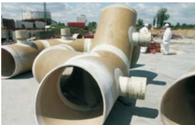
Serviss notekūdeņu attīrīšanas iekārtu būvlaukumā
