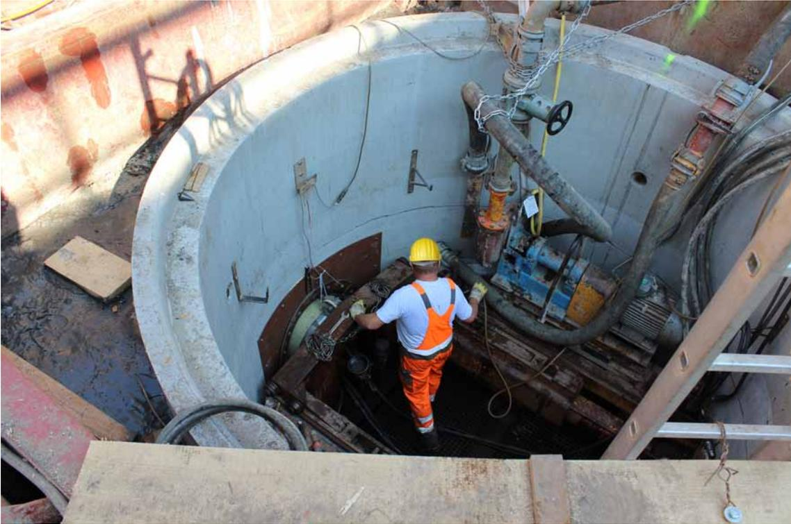
Beim Vortrieb wurde ein Microtunneling-Verfahren mit flüssigkeitsgestützter Ortsbrust und Spülförderung eingesetzt.
