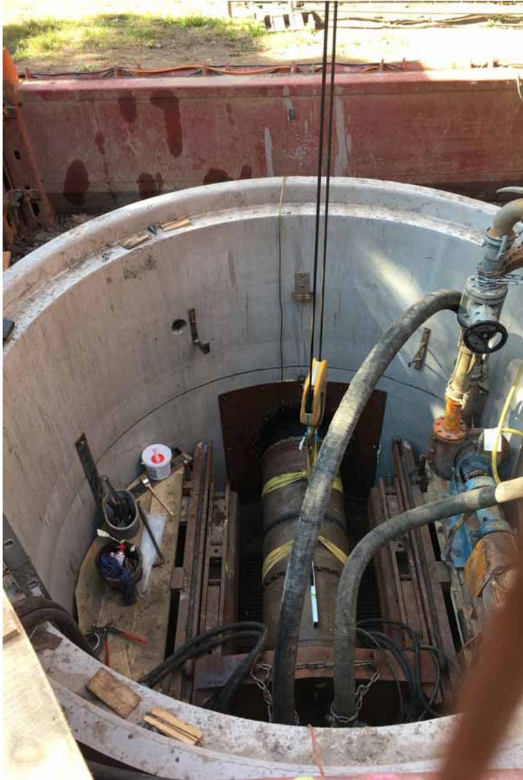
In Vorbereitung auf die Vortriebsarbeiten wurden beidseitig des Bahndamms Absenkschächte als Start- und Zielgrube abgetäuft.
