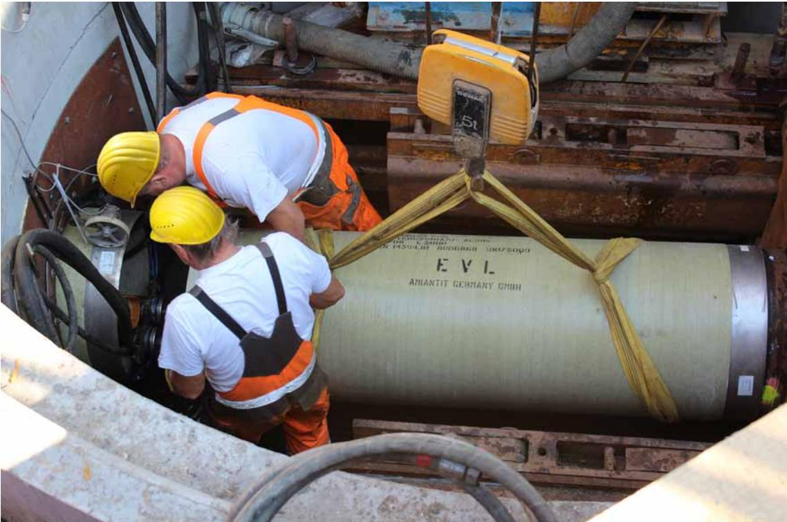
Für die Unterfahrung des Bahndamms kamen GFK-Vortriebsrohre DN 650 zum Einsatz, die mit einer Edelstahl-Kupplung ausgerüstet sind.
