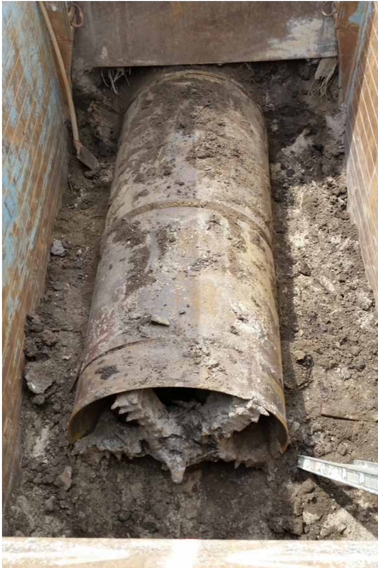
Ankunft der unbemannt arbeitenden Vortriebsmaschine im der Zielbaugrube.
