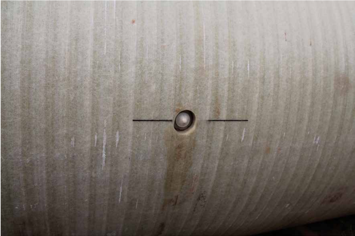
Stutzen für die Injektion der Bentonitsuspension in den Ringspalt.
