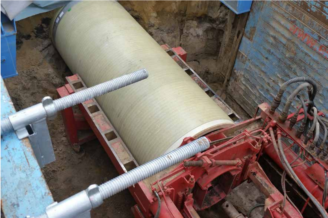
Blick in die Startbaugrube auf die Hauptpresstation.
