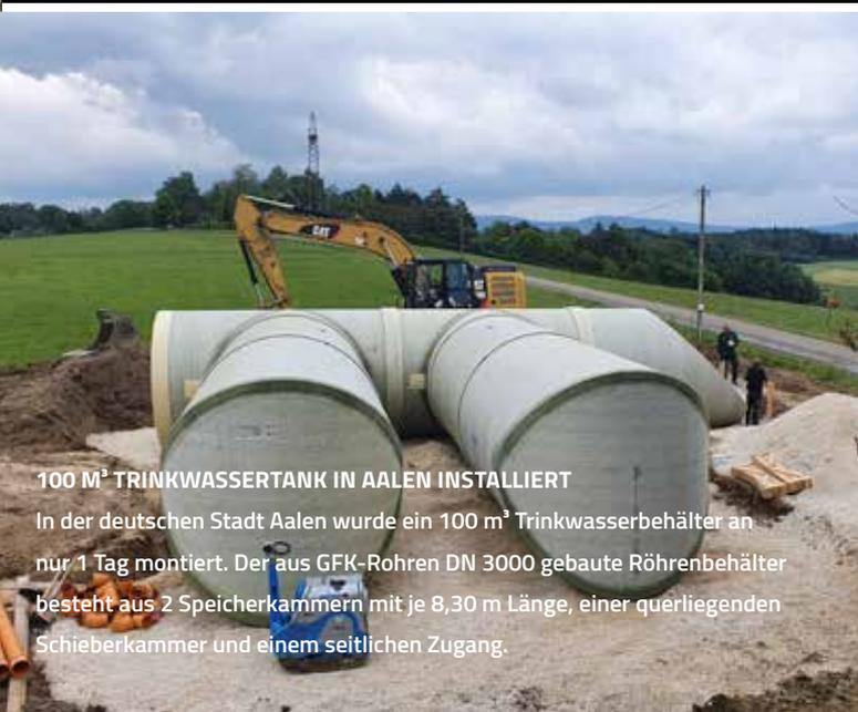
**100 M<sup>3</sup> TRINKWASSERTANK IN AALEN INSTALLIERT**
