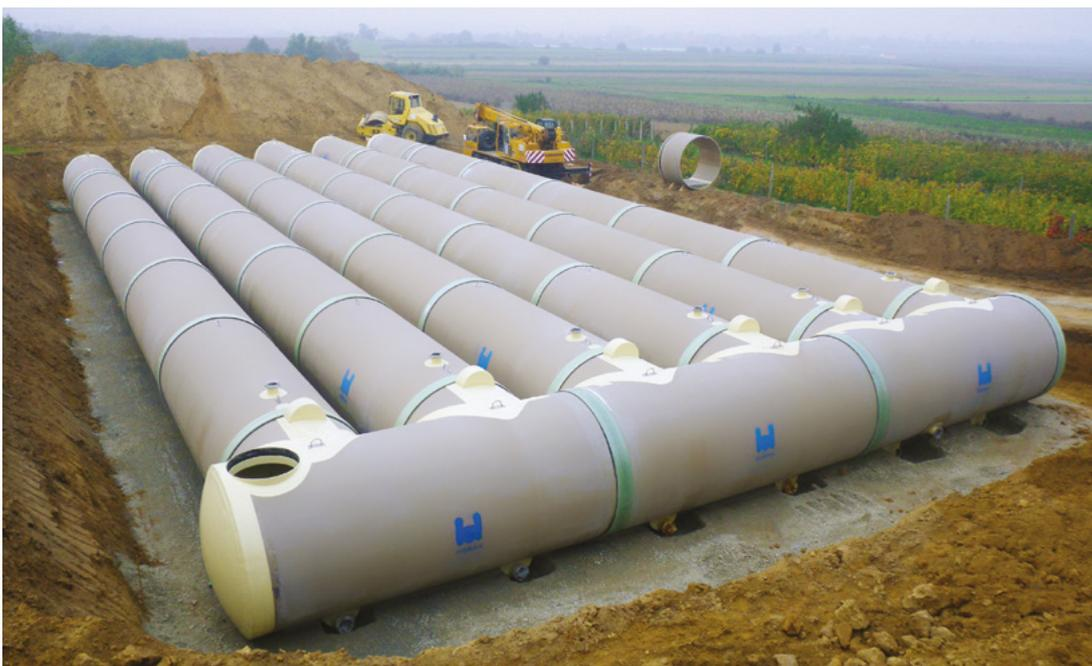
Diamètre (DN) jusqu'à 3600 mm
