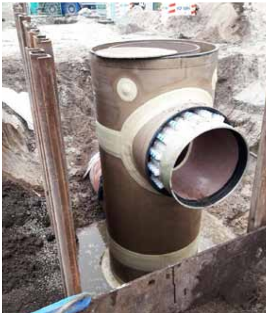
Left: Double manhole DE 1434 / DE 1026.
