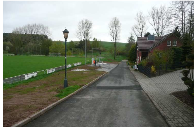
Nach der Fertigstellung
