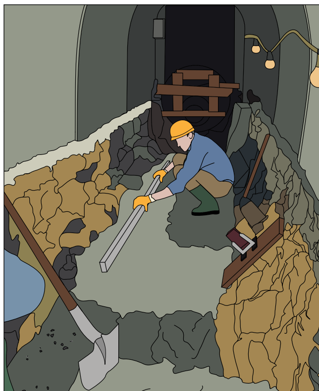
Fig. 17: Tratamento do fundo do esgoto atual para uma instalação correta
