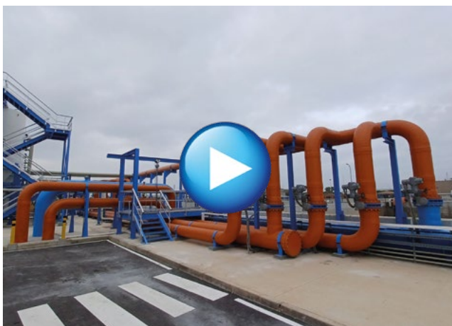
Video: Rury GRP w ogromnej oczyszczalni ścieków w Hiszpanii
