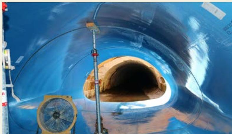
El revestimiento interior requiere una adaptación al perfil original. Las instalaciones de producción de Amiblu gestionan formas diferentes según las especificaciones. Los ingenieros de Amiblu están a su disposición para ayudarle en el diseño.
