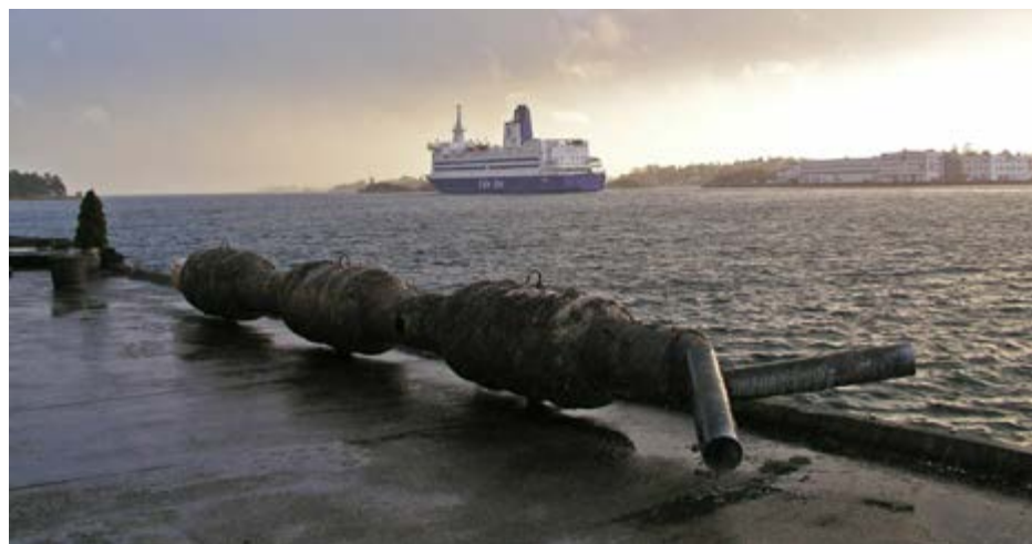
Fig. 12-13: Conduite Flowtite ramenée à terre pour analyse de son état et de ses propriétés mécaniques après 33 ans d'exposition aux eaux usées et à l'eau de mer (gauche). Après nettoyage de certaines parties du tuyau, celui-ci apparaît presque neuf (droite). La conduite ne montre aucun signe visible de vieillissement et ses propriétés mécaniques restent pratiquement inchangées. Pour en savoir plus sur ce projet, consultez les pages 10 et 11.
