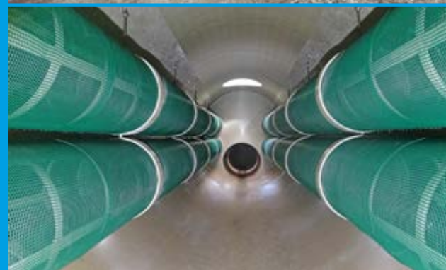
Ci-dessus: vues extérieure et intérieure du système de stockage Flowtite avec système intégré Amiscreen
