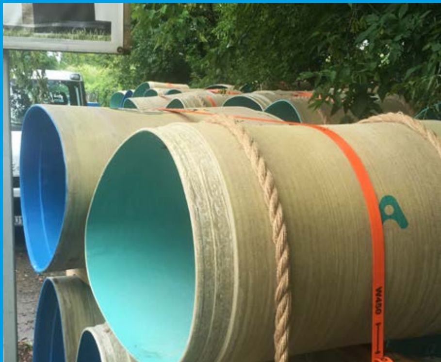
Ci-dessus: 746 m de tuyaux NC Line Amiblu ont été installés en huit mois dans le cadre de la rénovation de certaines parties obsolètes du réseau d'assainissement de Cracovie.
