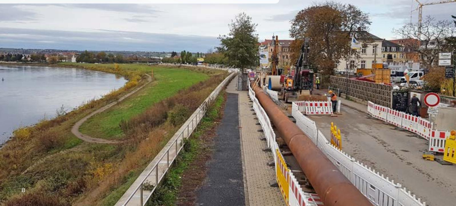
Avec une épaisseur de paroi d'environ 5 cm et un espace annulaire de 5 cm entre l'ancien ouvrage et le nouveau, le diamètre de la nouvelle conduite n'est que légèrement plus petit qu'avant.
