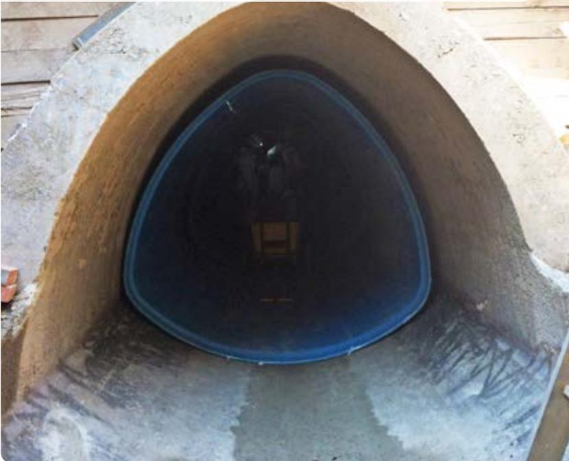
L'espace annulaire entre l'ancienne et la nouvelle conduite a été comblé à l'aide d'un coulis de remplissage...
