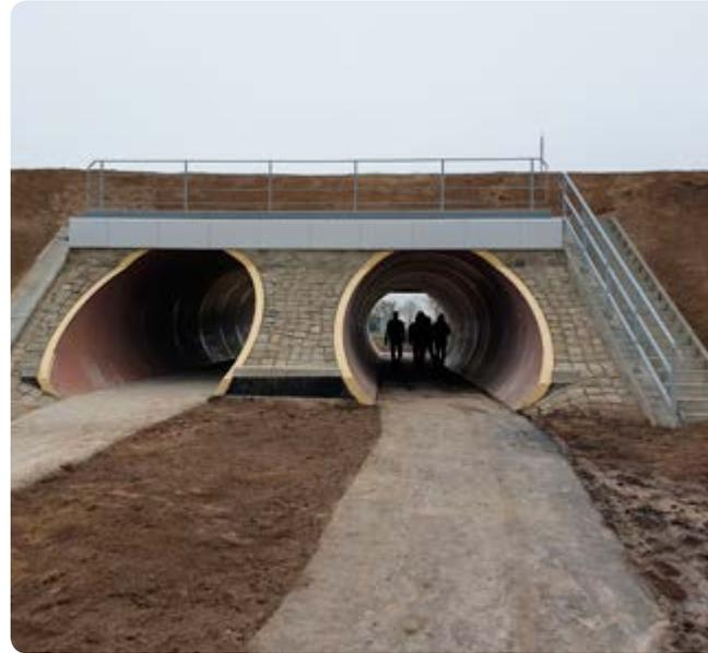
Deux lignes parallèles diamètre 3600 mm, d'une rigidité nominale SN 64 000 ont été fonçées sous les voies ferrées en exploitation en un mois environ. Pour aligner les extrémités du tunnel avec la pente du talus, des tuyaux biseautés sur mesure ont été installés. Pour finir, la génératrice inférieure a été bétonnée, un éclairage ainsi que des barrières de protection ont été installés, et les pistes piétonnes et cyclables ont été finalisées.
