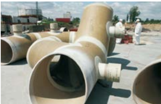
Servisas nuotekų valyklos statybos aikštelėje.
