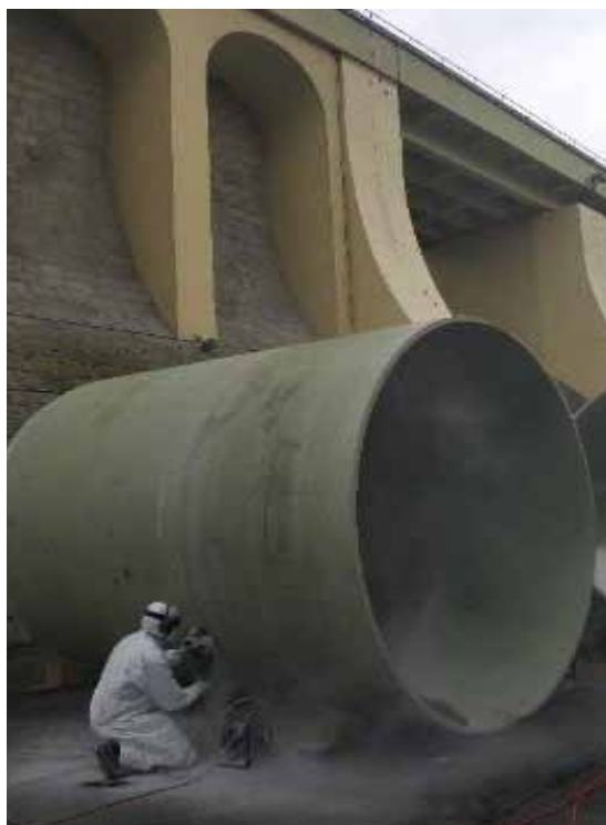
Fot. Przygotowania kształtki skośnej na budowie
