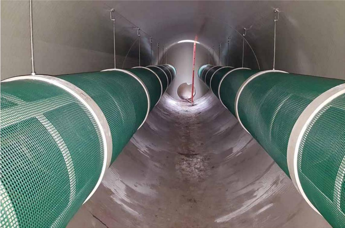
Beim AMISCREEN Stauraumkanal mit integrierter Grobstoffrückhaltung bestehen die Rechenelemente aus perforierten Rohren, die in dem Stauraumkanal fest montiert sind.
