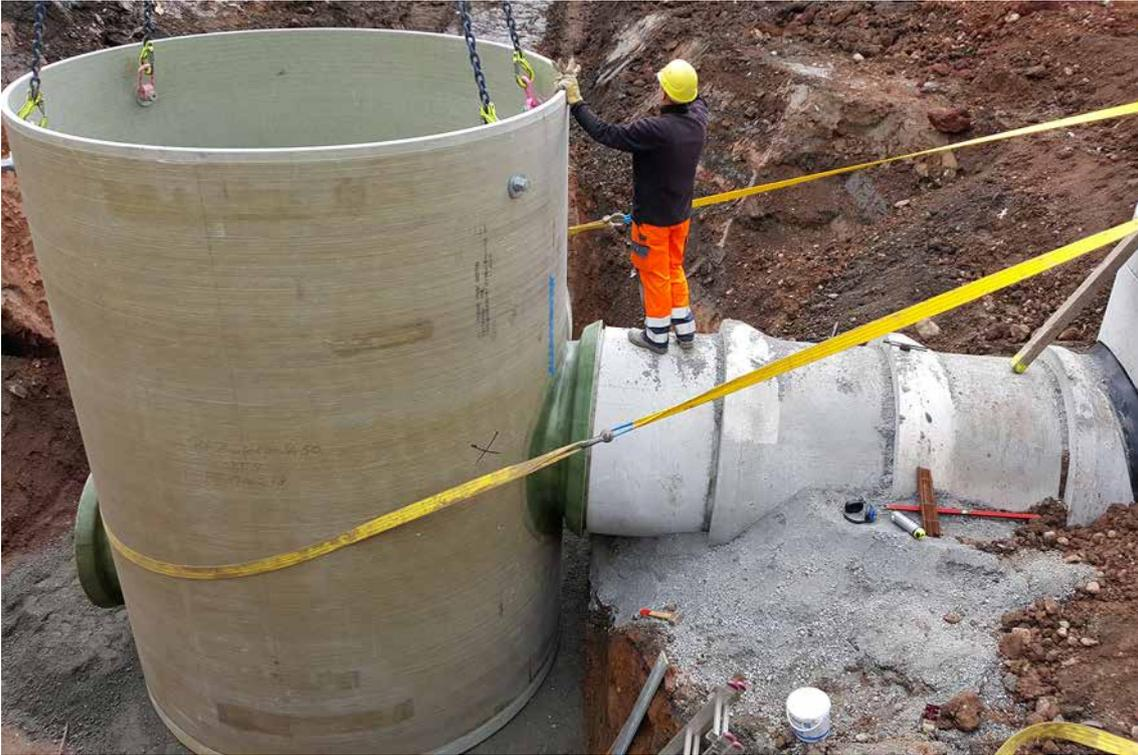
Der GFK-Entlastungsschacht ist am Überlauf mit einem Stahlbetonrohr DN 1200 verbunden, der in Richtung Zwickauer Mulde ableitet.
