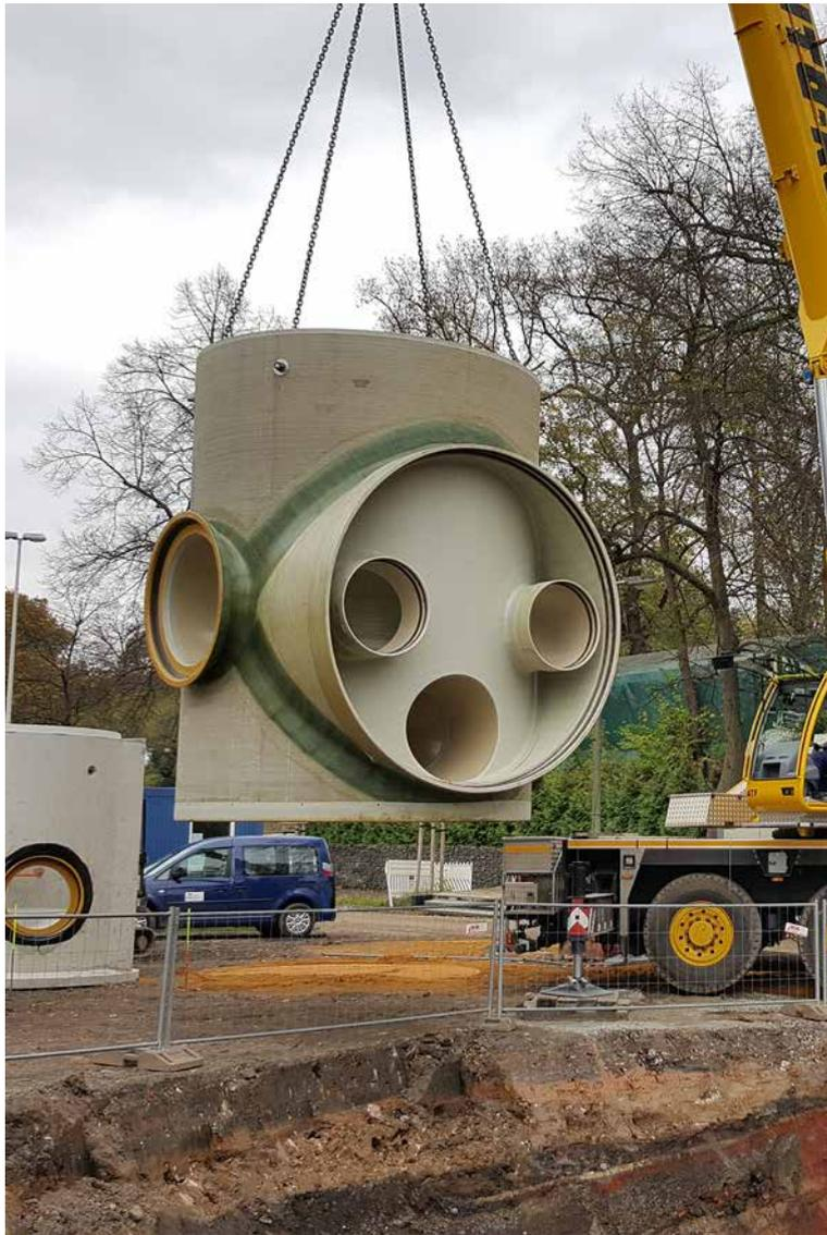
Einbau des GFK-Entlastungsschachtes DN 3200.
