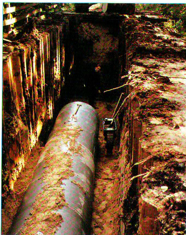
HOBAS-Rohre DN 1200 im verbauten Graben
