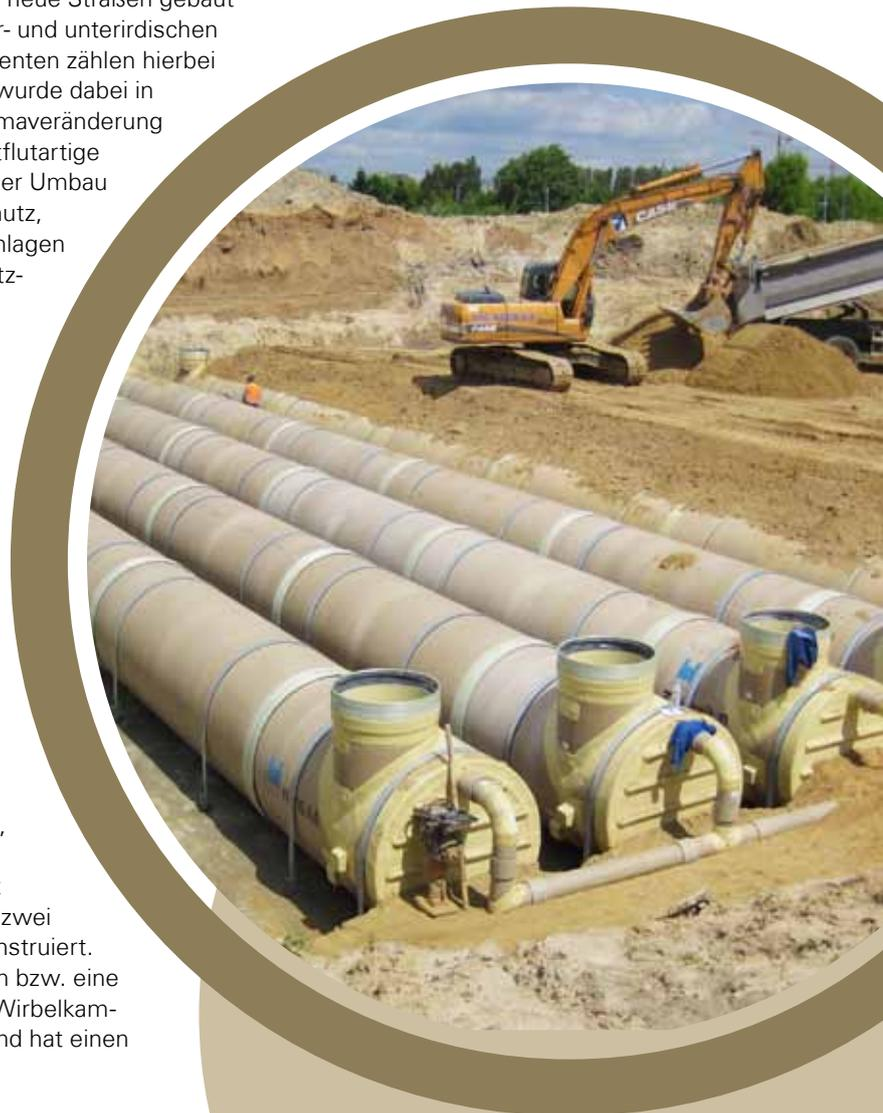
Die Straßenentwässerung der S79 umfasste die Verlegung von fünf GF-UP Becken DN 1800 mit Kapazitäten von 82 bis 956 m<sup>3</sup>. Bei der S2 kamen sogar 11 Behälter zum Einsatz. In den parallel verlegten Becken können beim Durchmesser von DN 3000 pro Tank 650 bis 3500 m<sup>3</sup> Wasser gespeichert werden.
