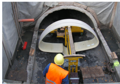
Bild 7, 8: Passprobe des Neuprofiles und Einbau
