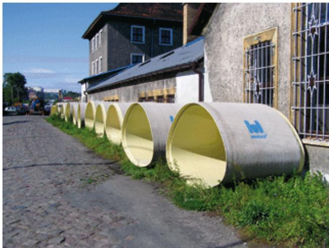
Um die neuen Profile sicher in den alten Kanälen zu verankern und sie vor dem Grundwasserdruck zu schützen, wurden die Leitungen in den alten fixiert und so Wölbungen bzw. ein Aufschwimmen verhindert. Anschließend wurde der Ringraum zwischen den Rohrleitungen verfüllt.
