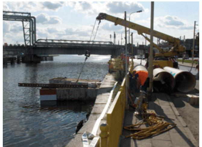
Die Arbeiten begannen im Dezember 2004. HOBAS lieferte Ei- und Maulprofile mit dem Querschnitt 400/543 mm bis 2626/1540 mm und Reliningrohre De 960 bis De 1434, SN 5000 bis 20000 inkl. Vortriebskupplungen. Die Bauarbeiten vor Ort wurden vom Unternehmen INFRA durchgeführt. Die Rohre und Profile wurden dabei von bestehen-
