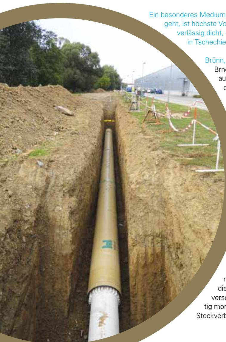
diese FWC-Kupplungen auch Raum für Abwinkelungen und sind daher in Kurvenabschnitten eine perfekte Alternative zu kostspieligen Formteilen. Sobald ein Rohrabschnitt fertig gestellt war, wurden die Enden mit einer Gummidichtung verschlossen, um Verschmutzungen der Rohrleitung zu verhindern.
