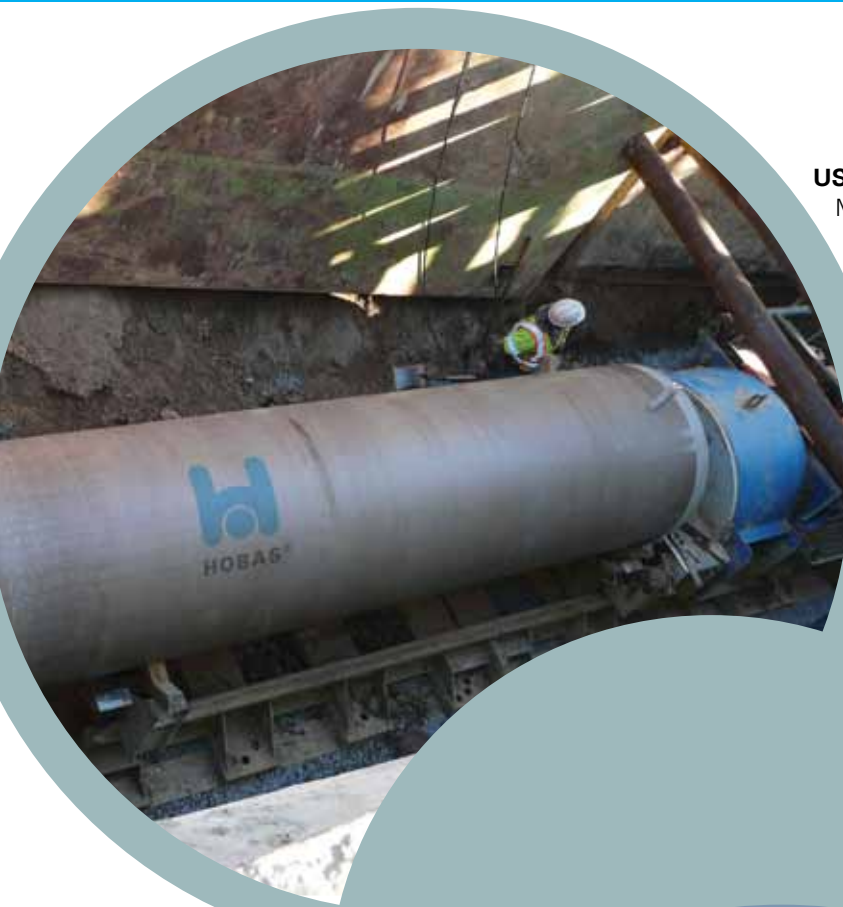
HOBAS Rohre mit Doppelfunktion in den USA: zum Schutz von Abwasserrohren und einer darüber verlaufenden Kerosinleitung
