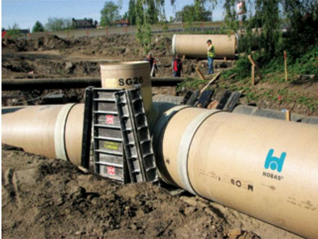
Da die Überdeckung des Kanals sehr gering ist, sind die Rohre im Jahresablauf an der Oberseite großen Temperaturschwankungen von bis zu 40 Grad Celsius ausgesetzt, an den Seitenwänden ist die Rohrtemperatur hingegen das ganze Jahr über relativ stabil. HDPE hat einen wesentlich höheren Ausdehnungskoeffizienten als die HOBAS Produkte und unterschiedliche Temperaturen rund um das Rohr wären problematisch gewesen. HOBAS hingegen überzeugte die Baufirma mit den eindrucksvollen Rohreigenschaften.
